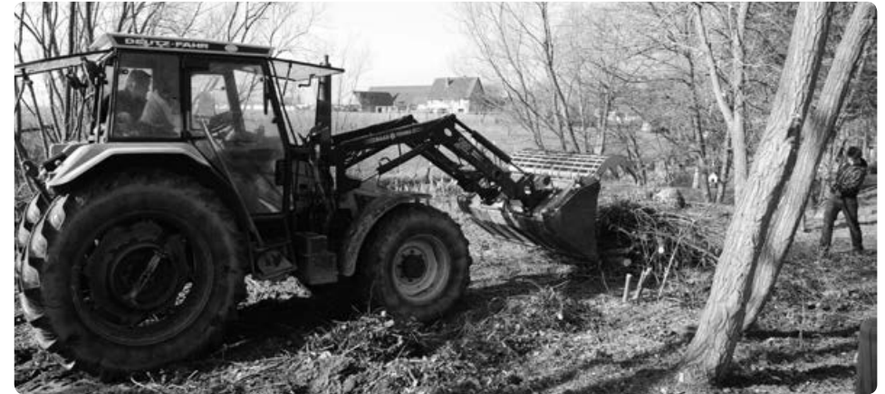
Auch „schweres Gerät“ kam im Pfarrgarten zum Einsatz.
