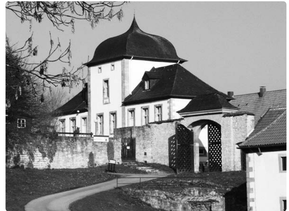
Ziel des jüngsten Gemeindeausflugs: die aufwendig sanierte und renovierte Klosteranlage Dalheim bei Paderborn. Foto: Unsere Kirche
